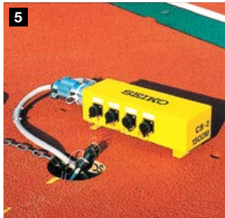
5 ハンドホールからの取出し
